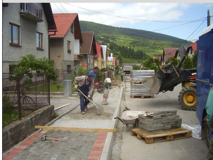
Jednostranný chodník na ulicu Hradý vybuďovala firma Roháče, s.r.o.
