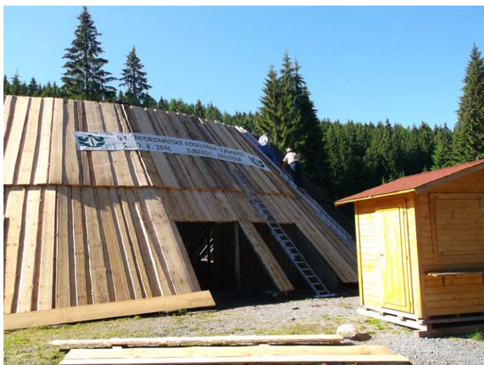
Amfiteáter – výmena strešnej krytiny
